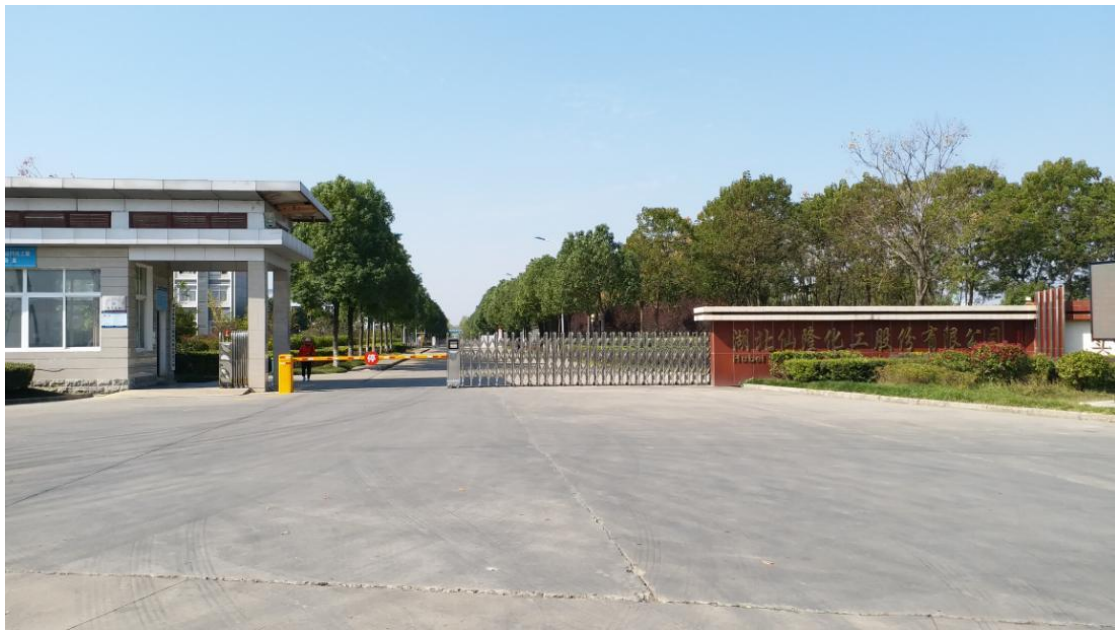
图 3-2 厂区东门现状图
